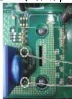
Contrôle tension DC
